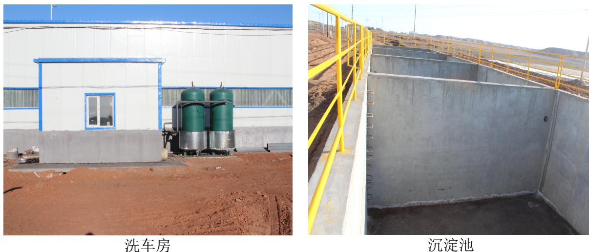
图 8.2-5 车辆冲洗废水处理设施现场照片
